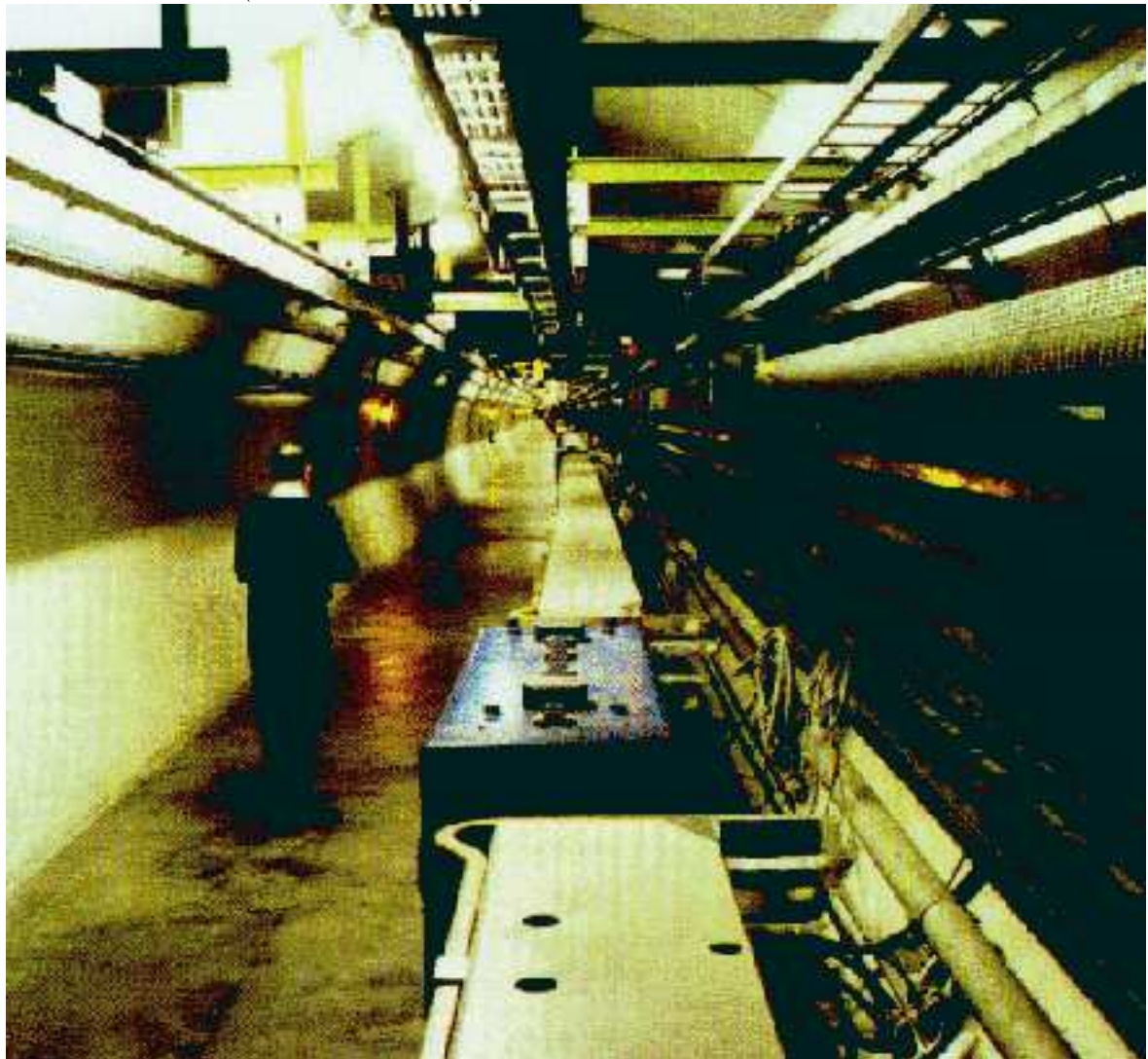
Figura 1.3: Uma fotografia do túnel subterrâneo de 3,8 metros de largura por onde passam os canhões de alumínio do LEP (à direita e embaixo).
